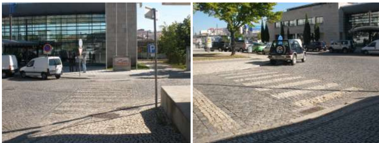
Figura 100. Condições de circulação pedonal na envolvente da estação ferroviária
